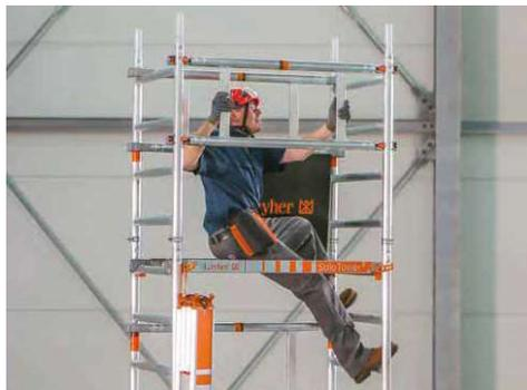
**Montagem apenas por uma pessoa** - Elementos compactos, de alumínio leve e de fácil manuseamento, que graças ao gancho de suporte de acessórios, podem ser manuseados e transportados de um nível para outro, o que facilita a montagem e desmontagem eficiente por uma única pessoa.
